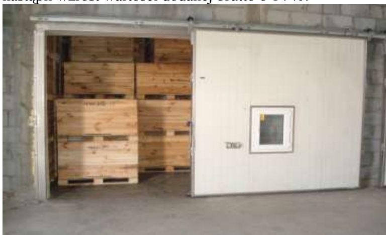
Fot. Rozbudowa przechowalni owoców
